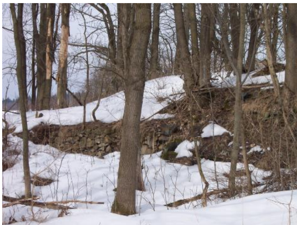
Obr. č. 3: Základy domů v zaniklém sídle Kolvín.
